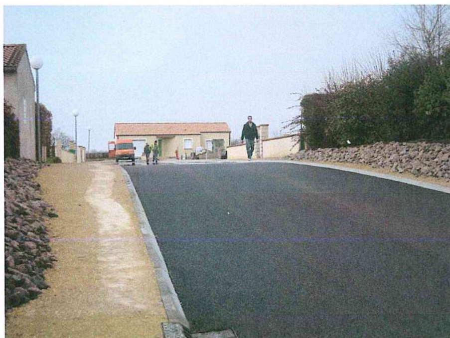
Fin des travaux du lotissement "Les Chaumeaux"
