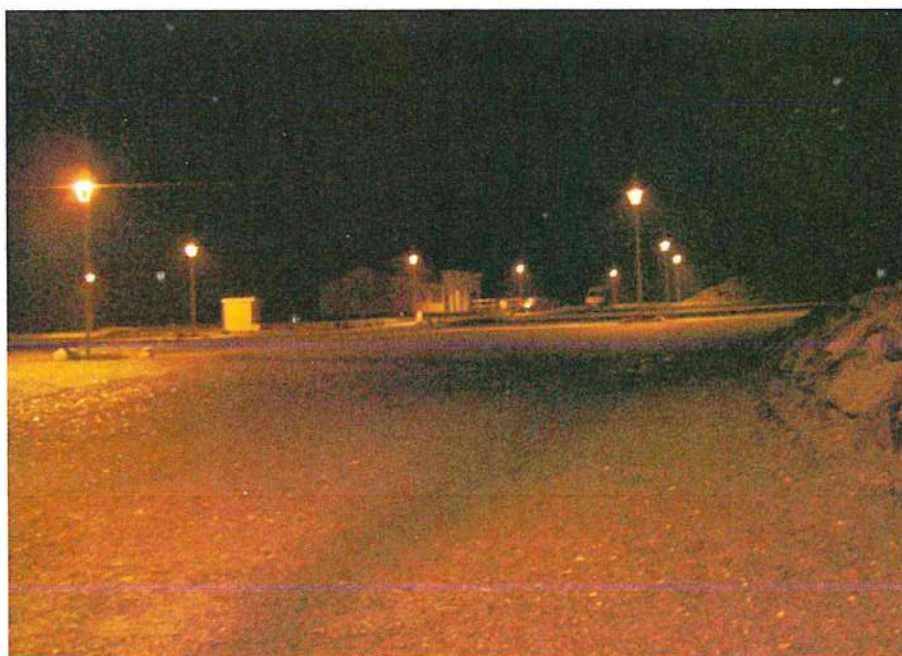
Eclairage public du lotissement "Le Chemin Vert"
